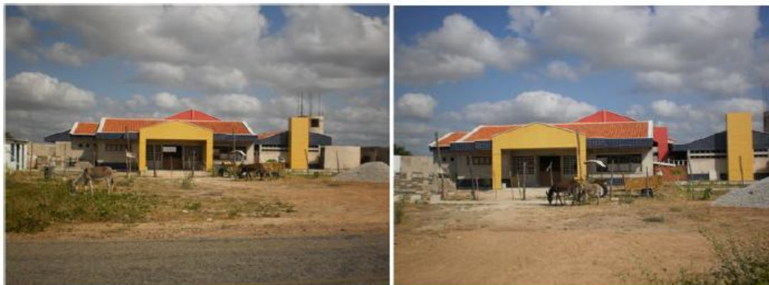
Figura 24. Construção da Creche-escola localizado no bairro São Geraldo Fonte: Autores (2011)
