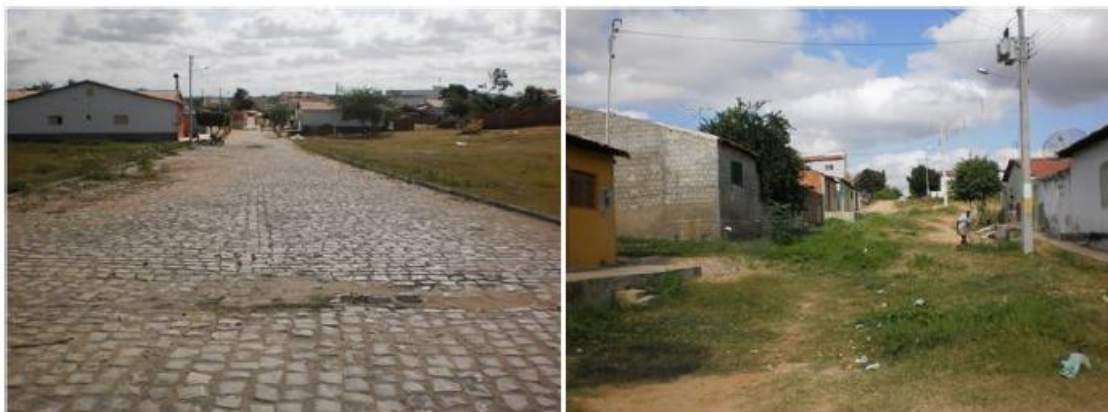
Figura 13. Rua Vicente Barros da Silva localizada no bairro Frei Damião Fonte: Autores (2011)
