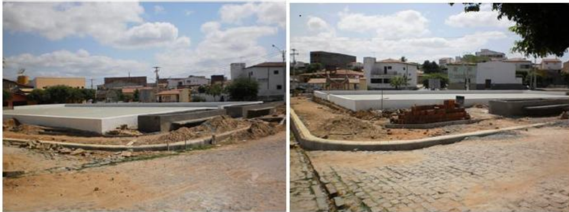
Figura 21. Reforma da Praça Israel Nunes no bairro COHAB Fonte: Autores (2011)
