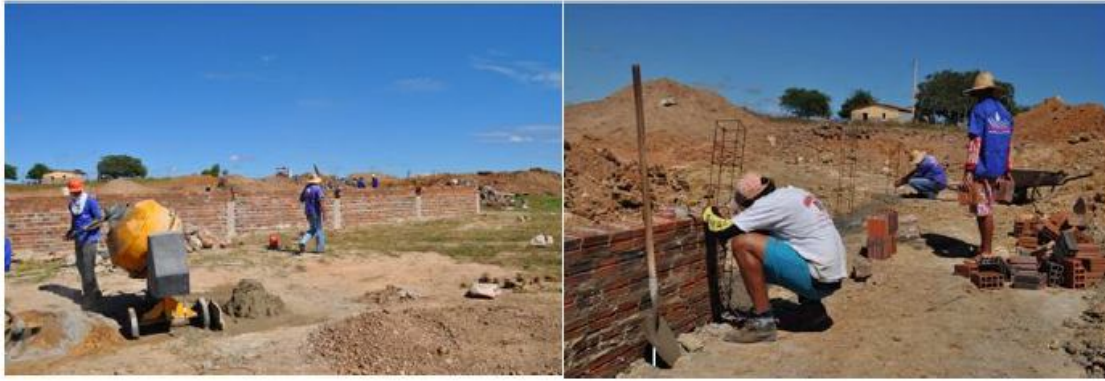
Figura 16. Construção do Complexo Esportivo localizado no bairro Nações Unidas Fonte: Autores (2011)
