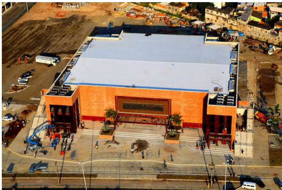
Figura 2: Obras de construção do Barra Music
