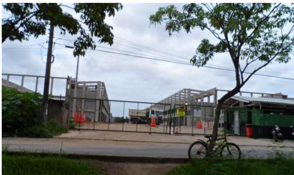
Figura 4: Obras do Uptown em 20 de março de 2013
