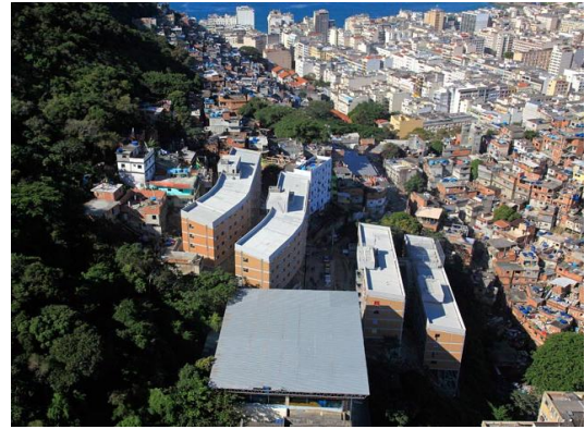
Figura 9: Conjunto de prédios do PAC inseridos na favela.
