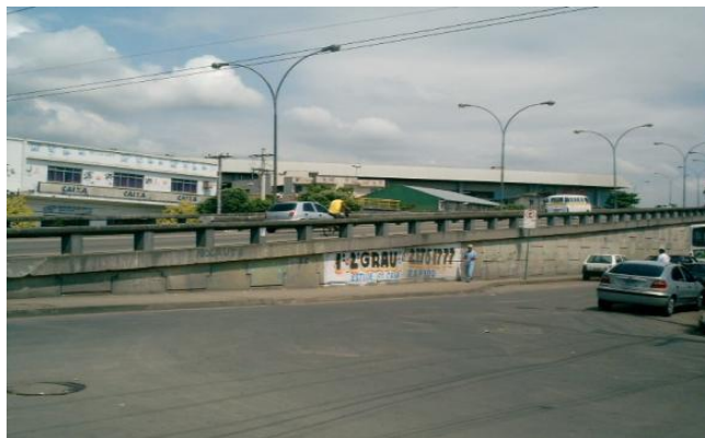
Foto 6: Viaduto da Pavuna na subárea 4 (2005).
