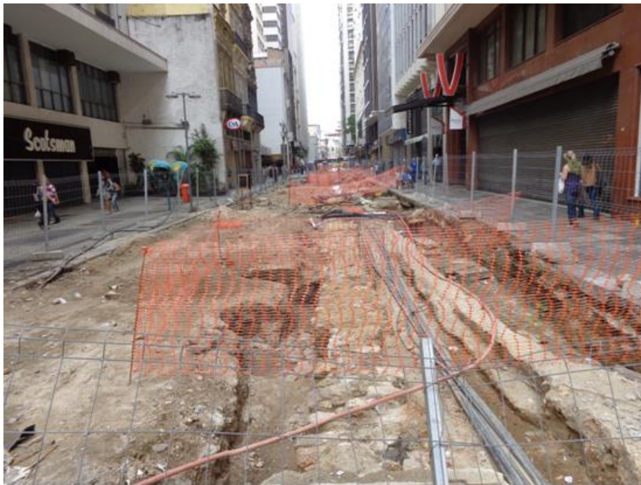
Foto 1: Obra de alteração da infraestrutura para implantação do VLT na Av. Sete de Setembro. Foto: Mauro Kleiman.
