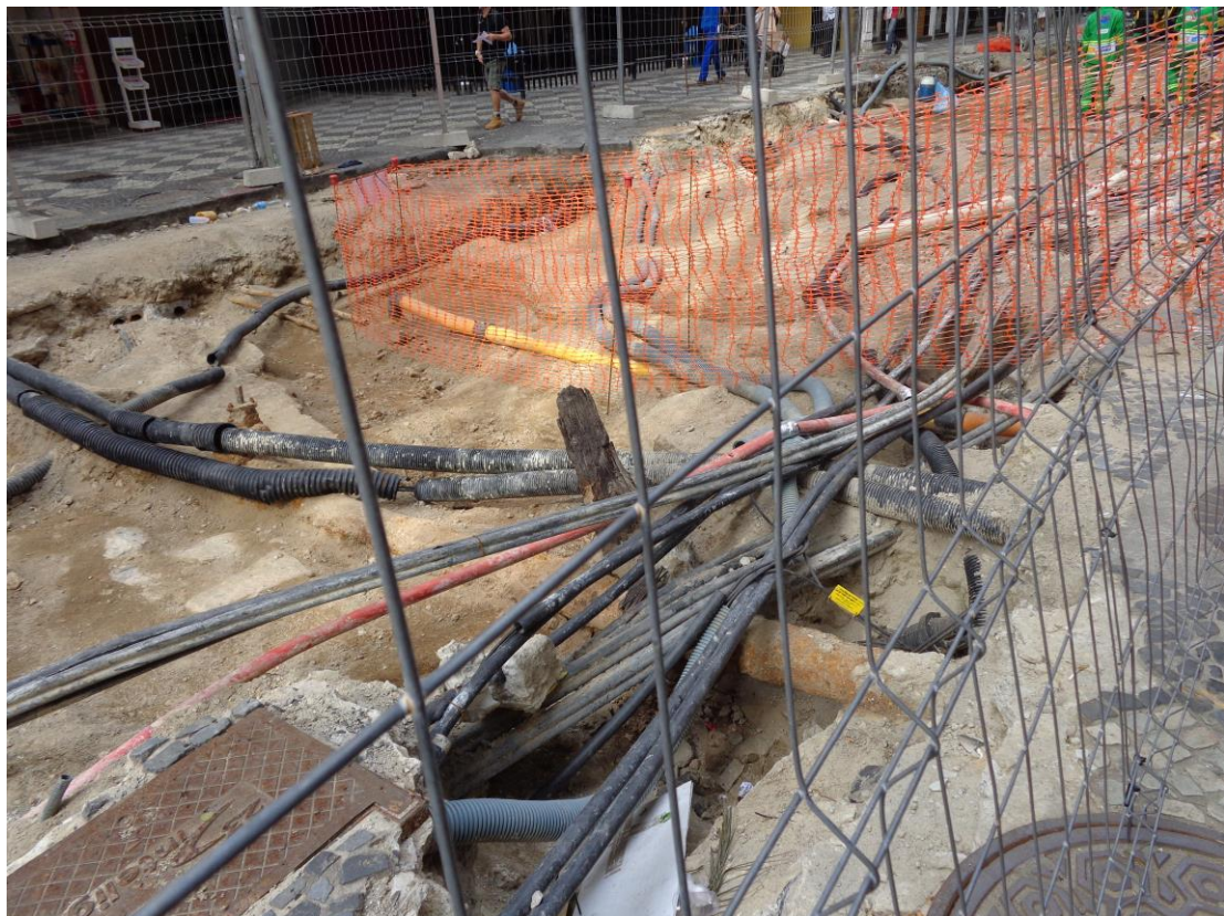
Foto 2: Obra de alteração da infraestrutura para implantação do VLT na Av. Sete de Setembro. Foto: Mauro Kleiman.
