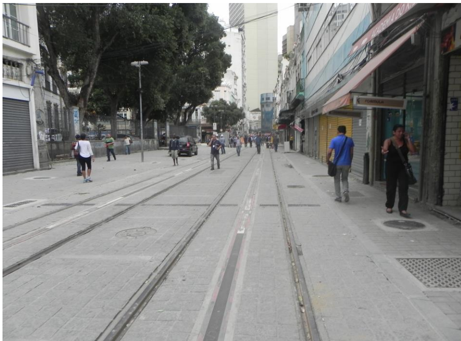
Foto 4: Via permanente já implantada em trecho na Av. Sete de Setembro.
